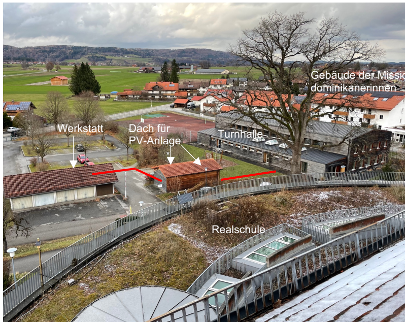
Abb. 1 Lage der Hausmeistergarage
