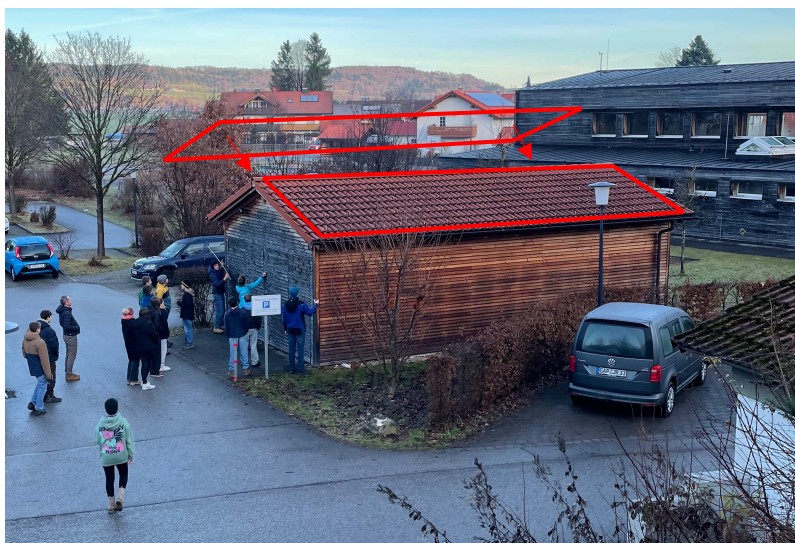
Abb. 2 Vermessen der Hausmeistergarage Rot: Flächen für die Panels.
