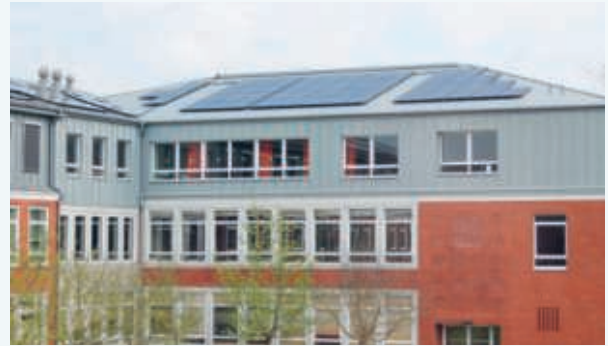
Große PV-Anlage auf Schuldach (Johannes-Althusius-Gymnasium, Albert Alberts-Tammena)
