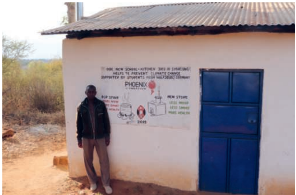
Schulküche mit holzsparendem Schulofen an der Syongungi Primary School, finanziert vom Phoenix Gymnasium Wolfsburg.
