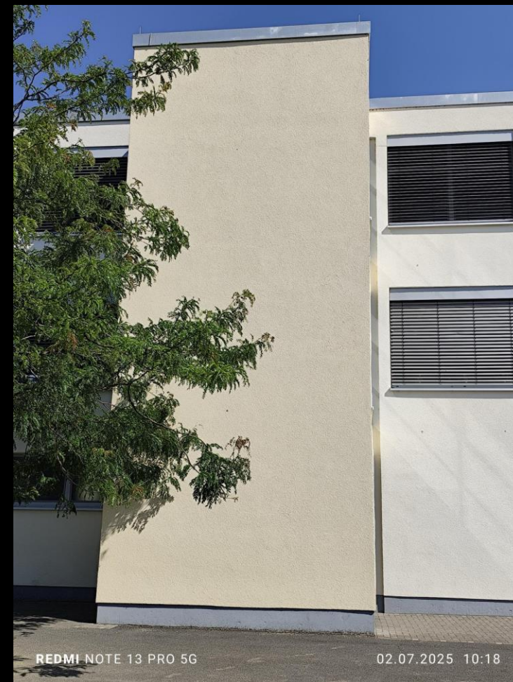
Gebäude 2 (Neben den Toiletten)
